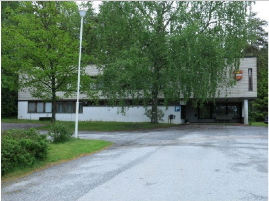
Entisen Kalannin kunnan kunnanvirasto, Kalantitalo, on rakennettu 1960-luvulla.
