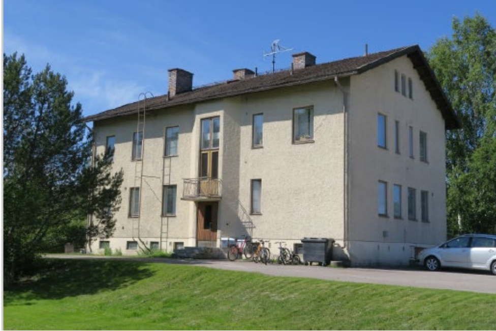
Tunnelitie 9 kaksikerroksinen rapattu rakennus on nykyään asunto- ja toimistokäytössä
