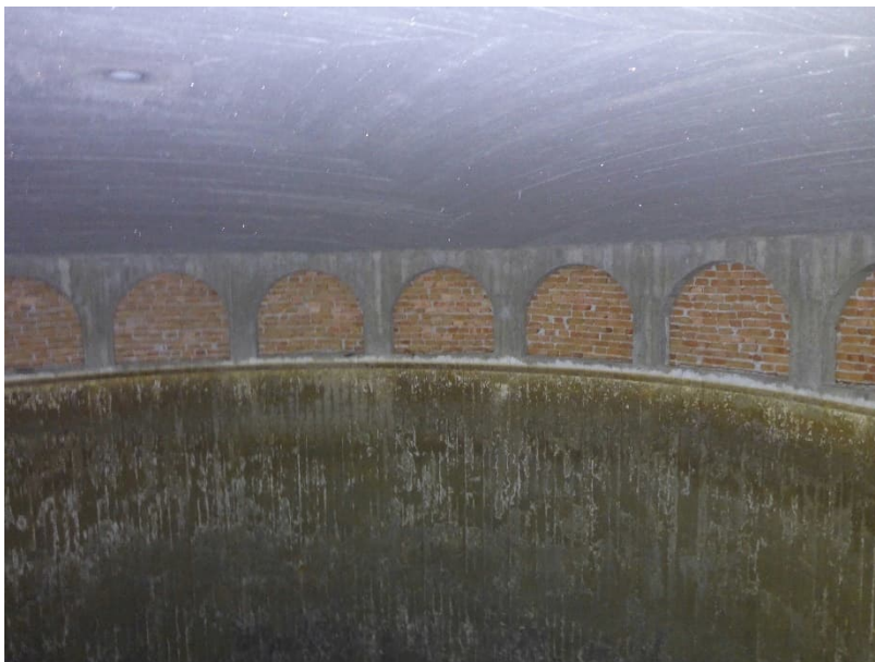
Kuva 15, säiliötilan holvikaarirakenteet
