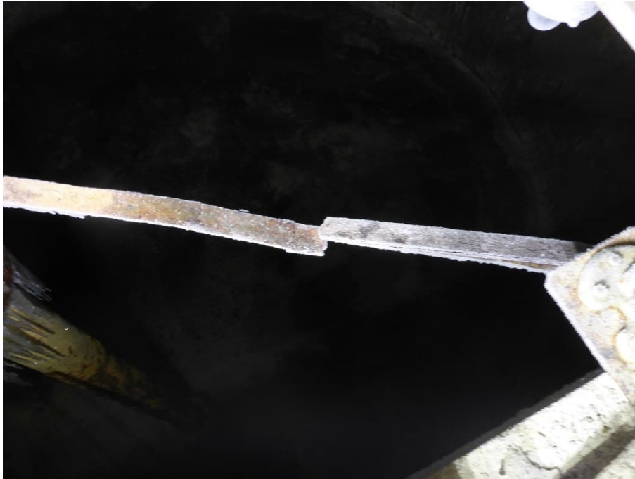
Kuva 17, ylivuotoputken tuki poikki
