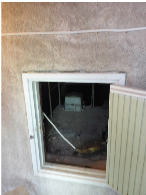
Kuva 14, kulkuluukku vesisäiliöön
