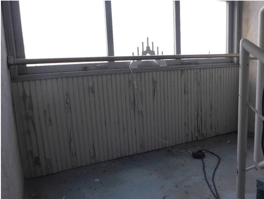
Kuva 10, uusittava julkisivuelementti
