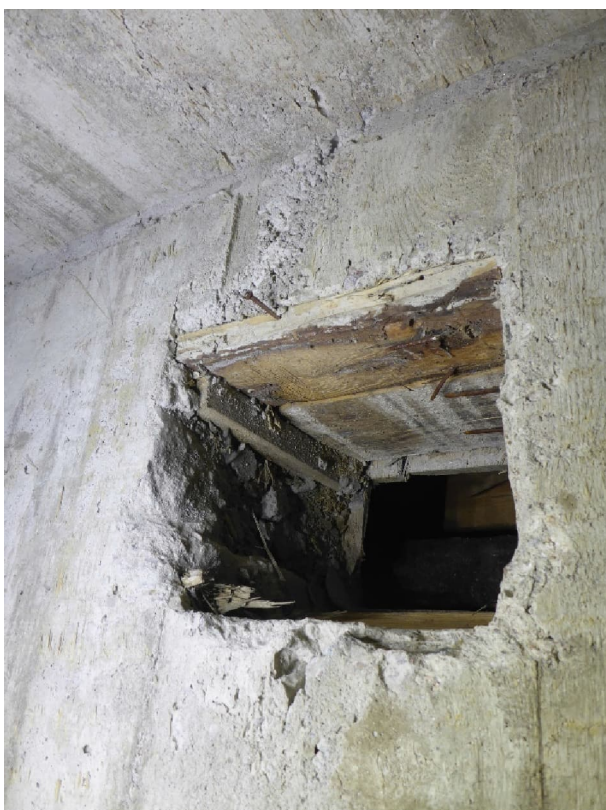
Kuva 12, muottilautoja välipohjassa
