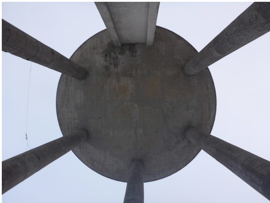
Kuva 13, säiliön pohjalaatta
