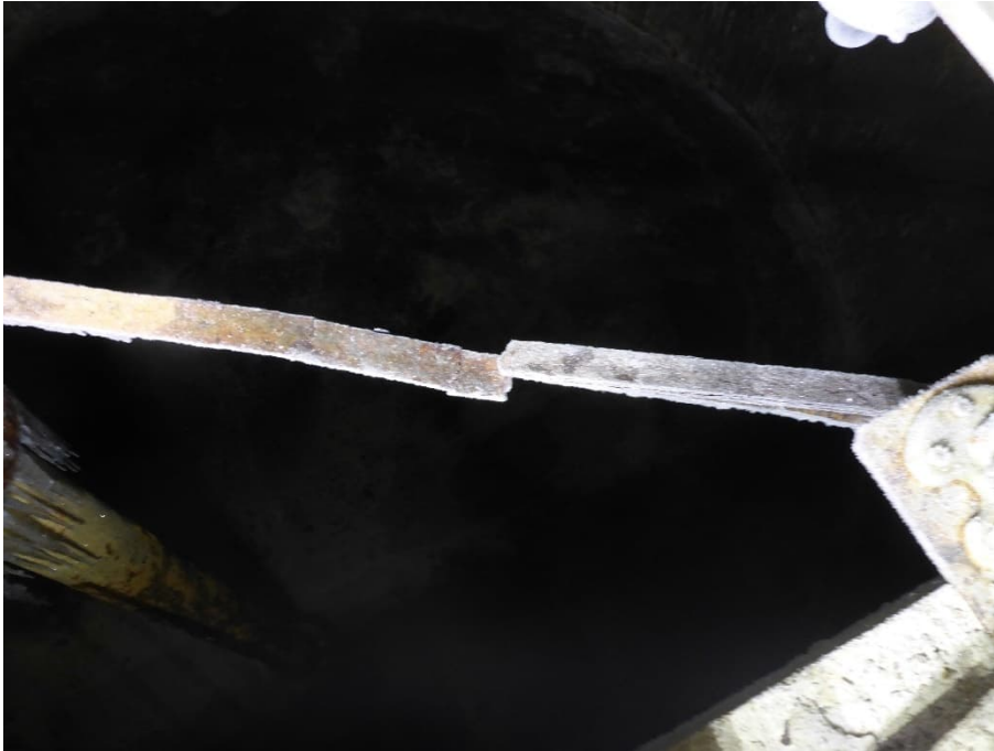
Kuva 17, ylivuotoputken tuki poikki
