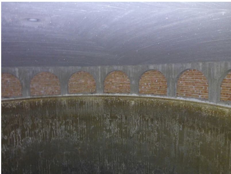
Kuva 15, säiliötilan holvikaarirakenteet
