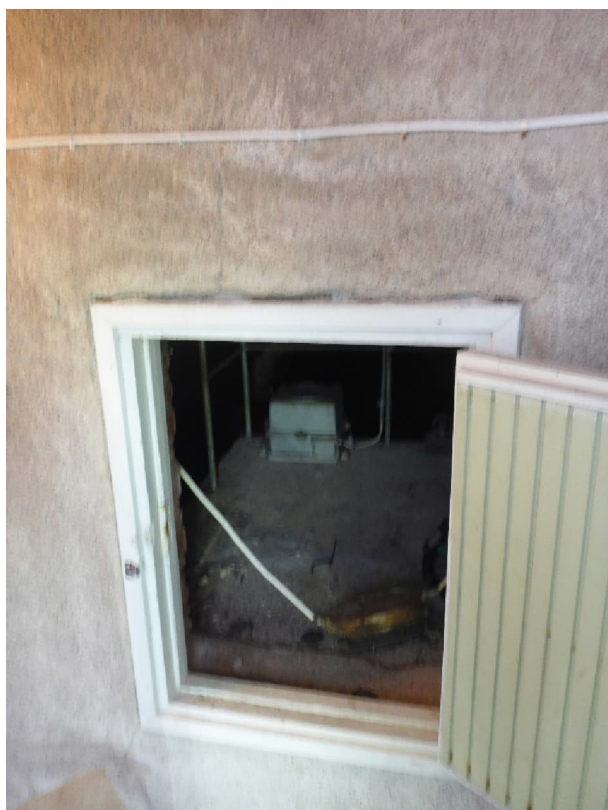
Kuva 14, kulkuluukku vesisäiliöön
