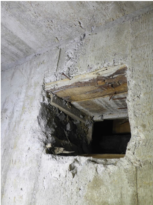
Kuva 12, muottilautoja välipohjassa
