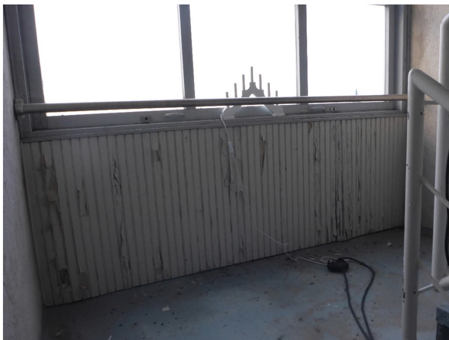
Kuva 10, uusittava julkisivuelementti
