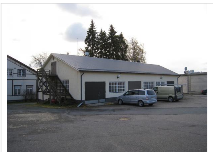
Luoteissivu ja koillispääty
