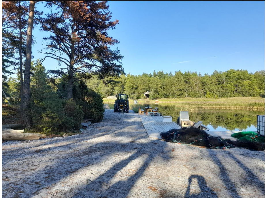
7. AL-alueen itäosaan rakennettu laituri
