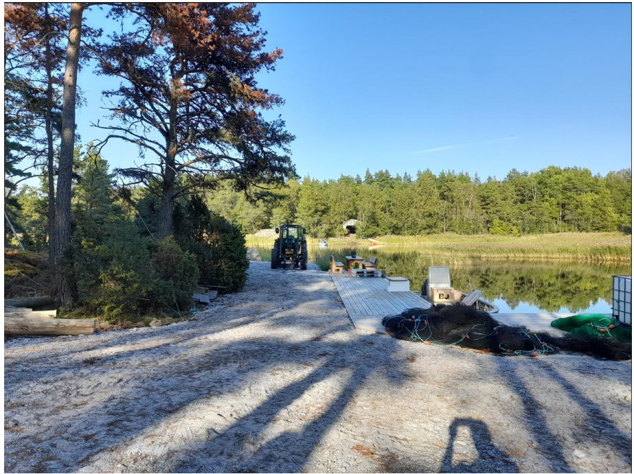
7. AL-alueen itäosaan rakennettu laituri
