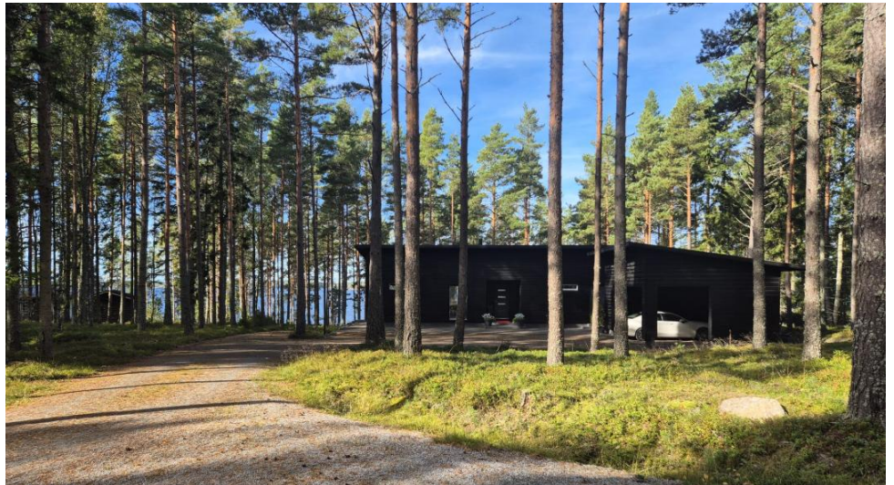
Kiinteistö -18 tieltä katsottuna
