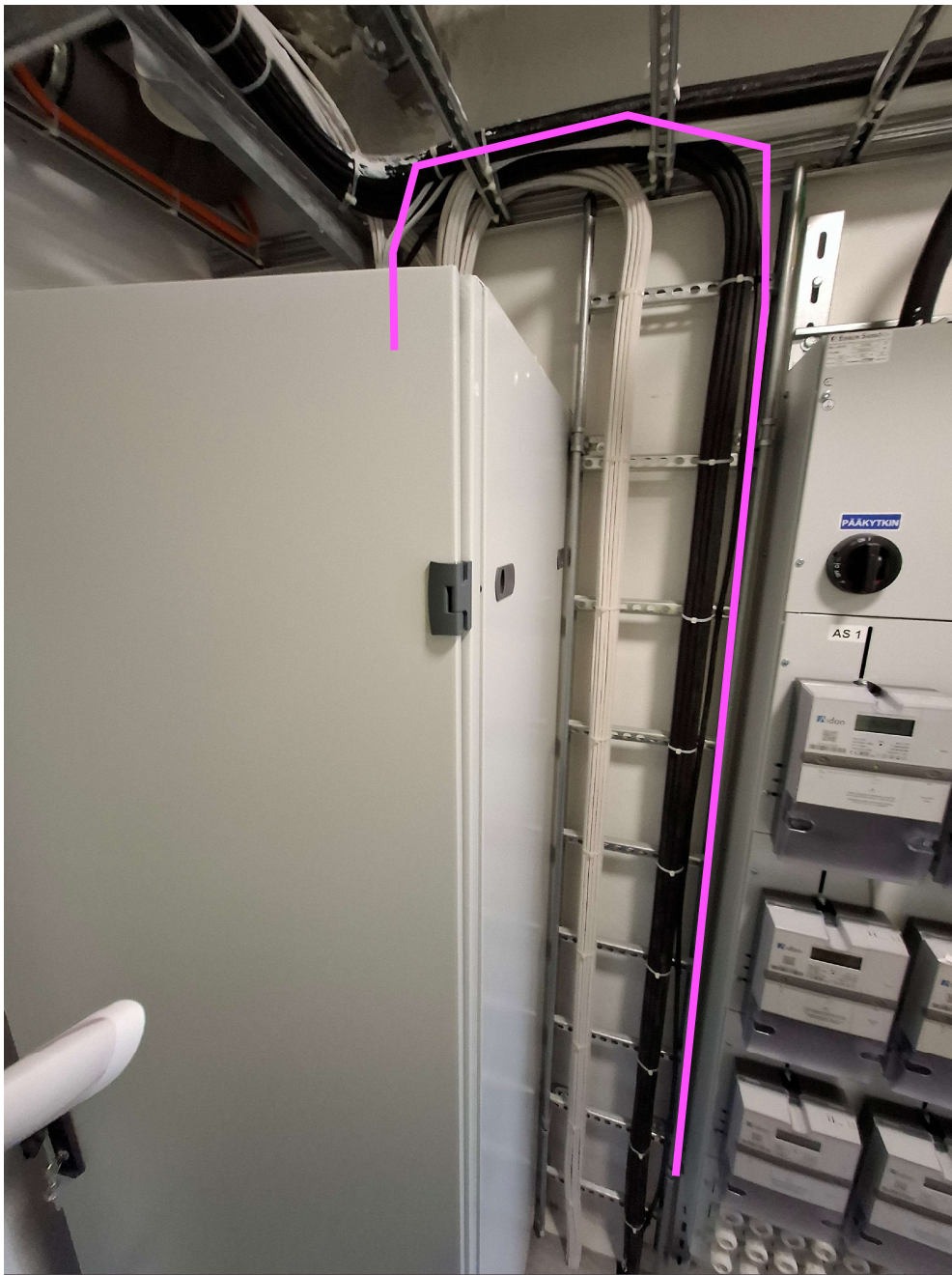
Tuodaan kaapeli kiinteistön arinaa pitkin olevaan ATK-kaappiin. Asennetaan kaappiin uusi 19"-paneeli ja päätetään kuitu siihen.
