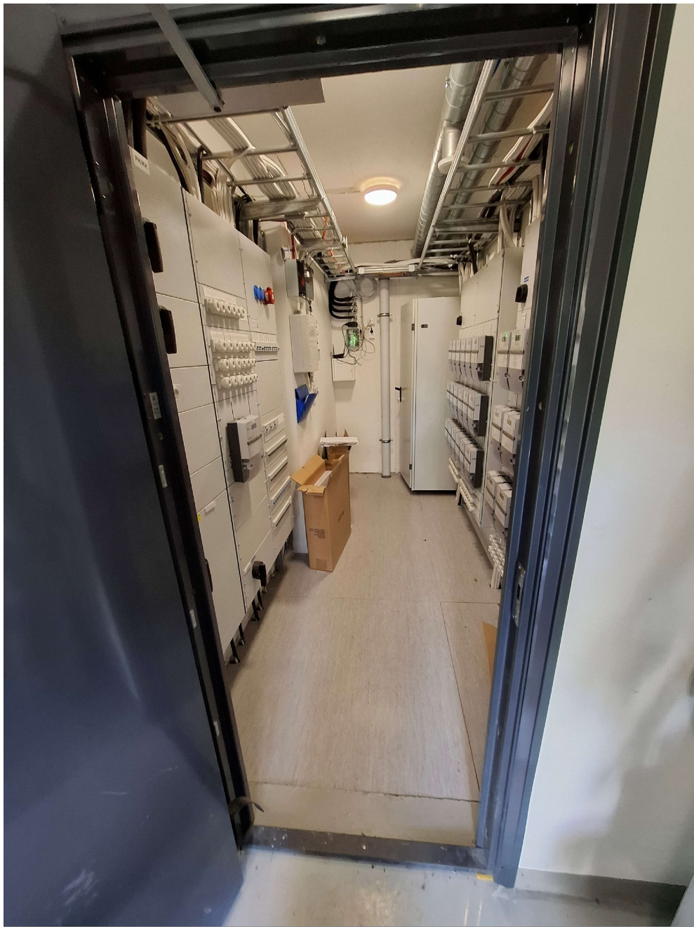
Tuodaan kaapeli kiinteistön arinaa pitkin olevaan ATK-kaappiin. Asennetaan kaappiin uusi 19"-paneeli ja päätetään kuitu siihen.
